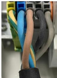
Minimum Querschnitt der Zuleitung ist 2.5 mm<sup>2</sup>. Unter Bedingungen kann ein höherer Querschnitt erforderlich sein.
